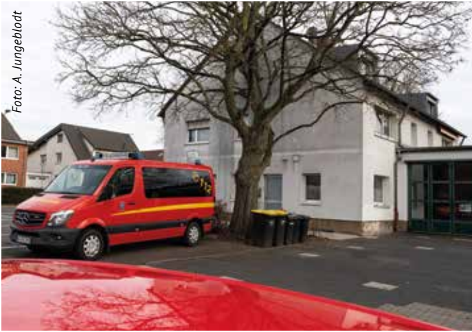
Beim Brandschutz liegt Einiges im Argen.
