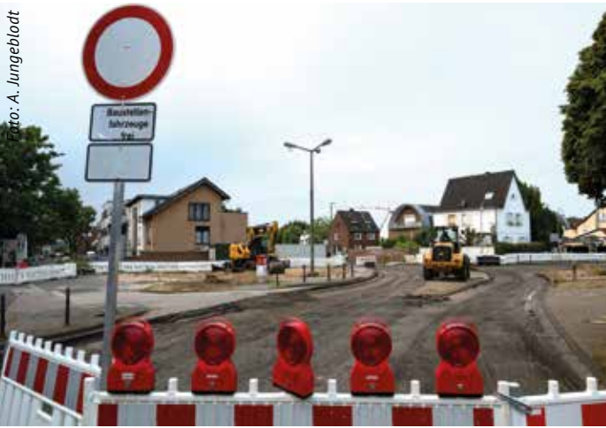
Die Bauarbeiten am „Kölner Tor“ haben begonnen.
